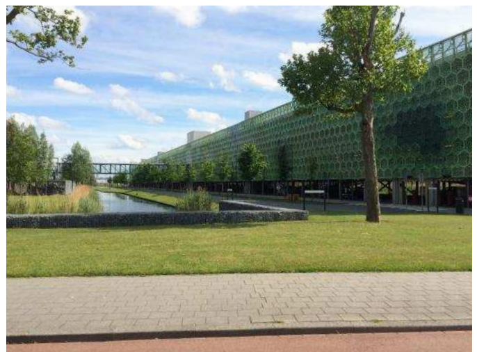
Landschappelijke inpassing van een parkeergarage, Rotterdam, Maasstad Ziekenhuis
